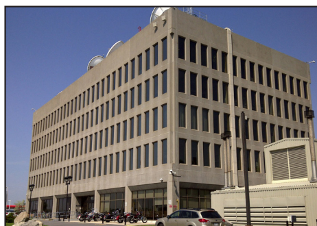
35 Canada Environnement Environnement Canada
