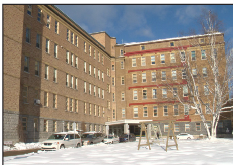
29 Baie-St-Paul Hospital Hôpital Baie-St-Paul
