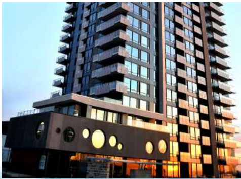
EvoloS Tower 121 de la Pointe N Road- Verdun, Québec, Canada
